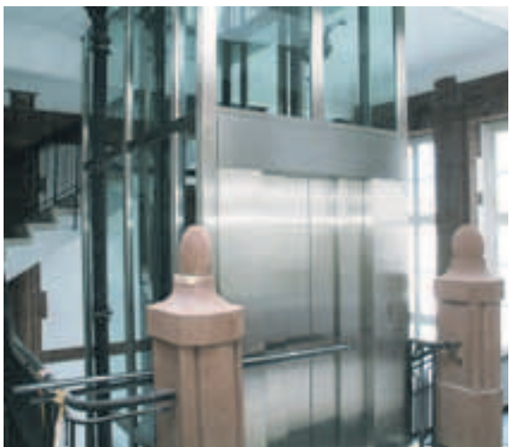
TRADITION UND MODERNE zeigen sich auch im historischen Treppenhaus. Das Geländer und die Handläufe sowie die eisernen Säulen wurden restauriert, der Fahrstuhl erneuert. Foto: Kai-Uwe Heinrich
